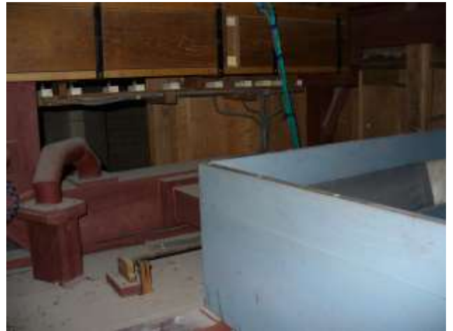
Le porte vent principal et le réservoir
